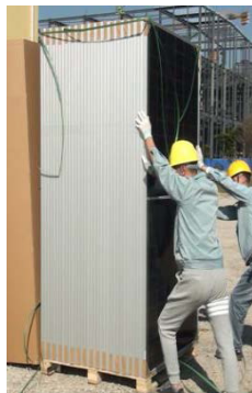
Coupez les 4 cerclages verticaux et poussez les modules sur le rack
